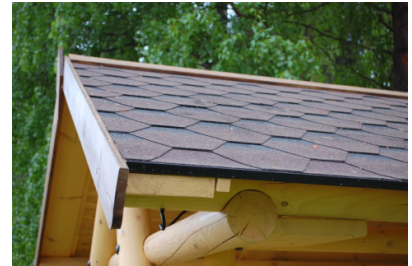
Fertigdach (vorgefertigte Elemente, Bretter mit Wassernut) oder Dachbretter-Set (zum Bedecken mit Dachschindeln o. Ä.)
