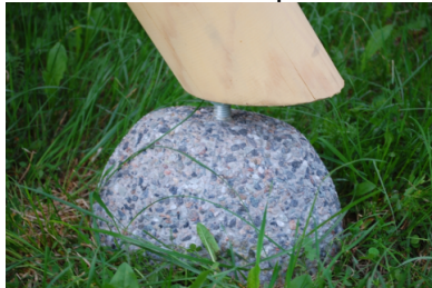
Fundament: Betonfüße
